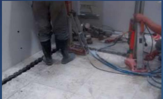
Foto 16 – Abertura em laje com sequência de furos para nova escada rolante de acesso
