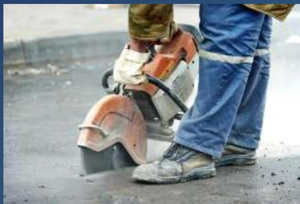
Foto 20 – Corte com serra diamantada manual a gasolina em asfalto
