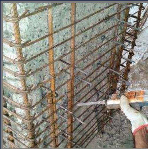
Foto 11 – Colagem do aço. Ampliação de pilar
