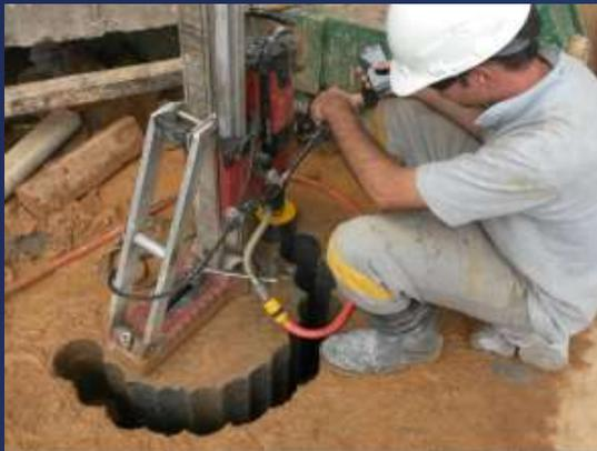
Foto 15 – Abertura em bloco estrutural para inclusão de estaca escavada
