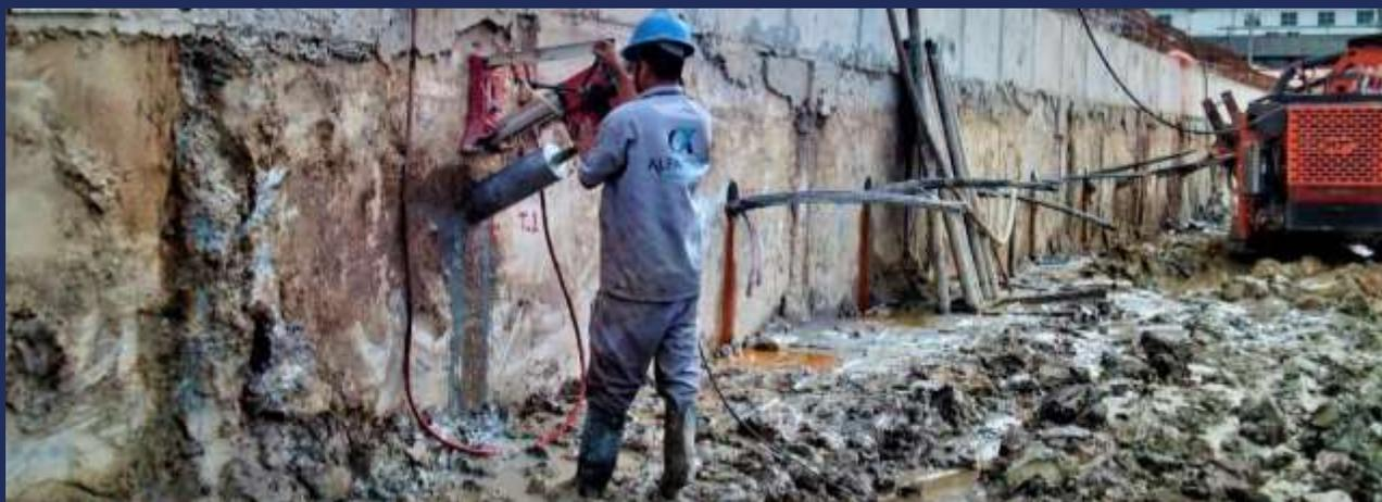
Foto 7 – Pré-furo para tirante de 6”1/4” com profundidade de 100cm, inclinação de 30 graus
