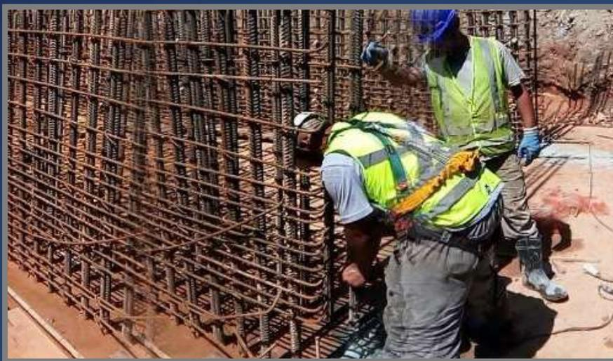
Foto 12 – Executando furos no bloco para adicionar aço
