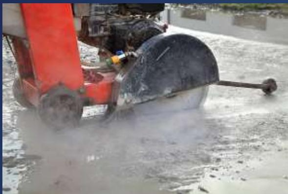
Foto 19 – Corte com Serra diamantada *Clipper* em asfalto
