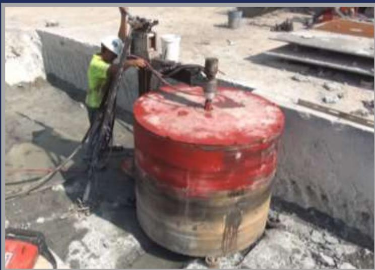
Foto 17 – Perfuração com broca de 60” – EUA – *Concret Cutting & breaking Co. Estaleiro LaShip*
