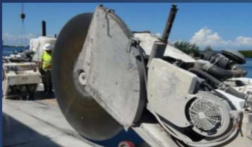
Foto 22 – Corte com disco diamantado, foto de *site* nos EUA. Unidade de corte a gasolina
