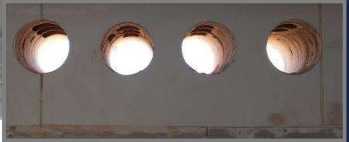
Foto 9 e 10 – Execução de furos para instalação de sistema de exaustão
