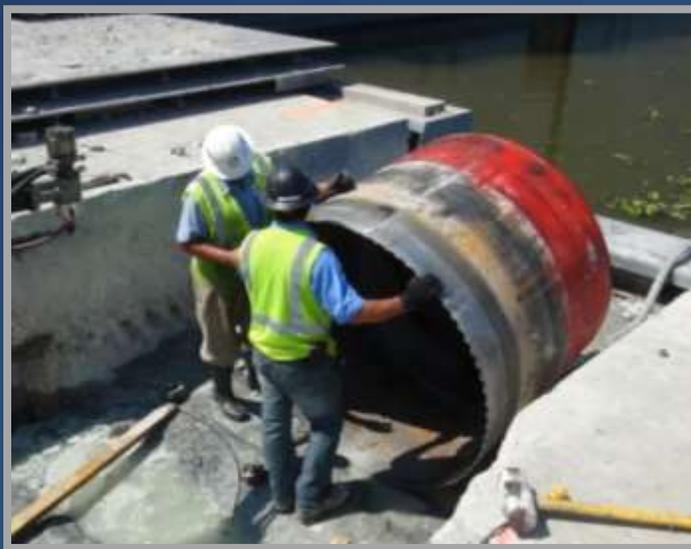
Foto 18 – Perfuração com broca de 60” – EUA – *Concret Cutting & breaking Co. Estaleiro LaShip*
