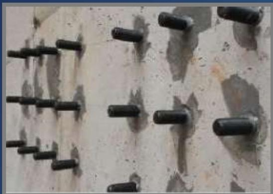
Foto 13 – *Inserts* para estrutura metálica
