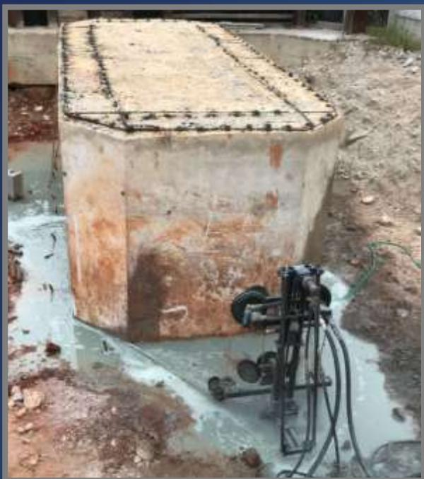
Foto 26 – Corte e remoção de bloco de concreto, 12m x 5m
