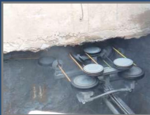
Foto 27 – Corte com fio, base instalada na vertical.
