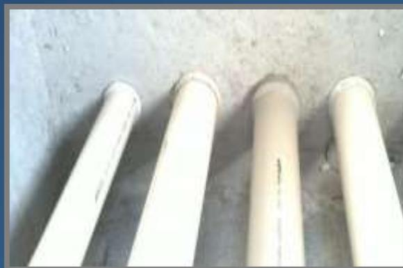
Foto 8 - Furos de hidráulica executados
