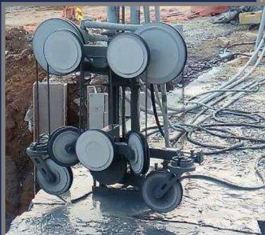
Foto 25 – Corte com fio em viga de coramento. Demolição
